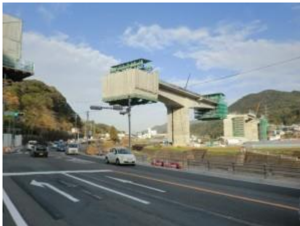
【施工中の八郎川橋りょう(H30.12 撮影)】
