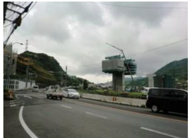
【施工中の八郎川橋りょう(H30.6 撮影)】
