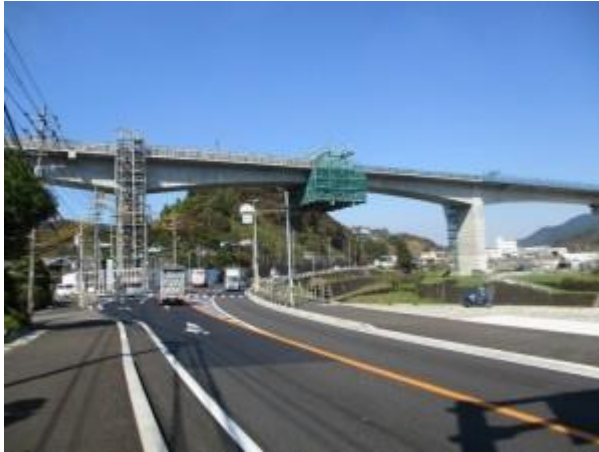
【閉合した八郎川橋りょう(R1.10 撮影)】
