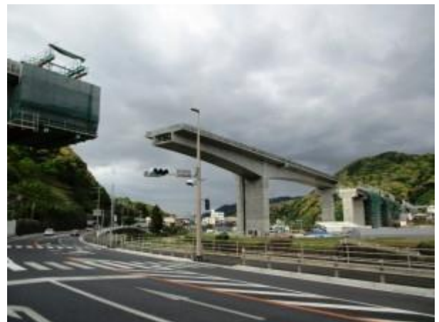
【施工中の八郎川橋りょう(H31.4 撮影)】
