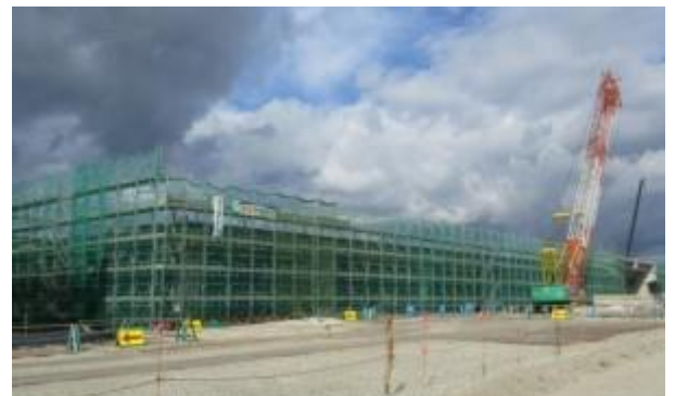
【建設地の現況(高架橋建設中)】
