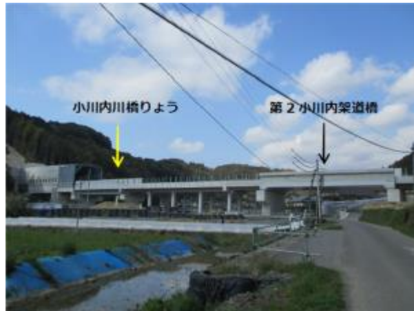
【小川内町付近にて完成した橋りょう】
