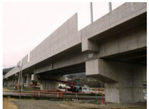
【完成した平町架道橋】
