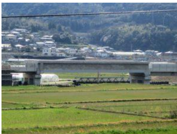
【完成した鈴田川橋りょう】
