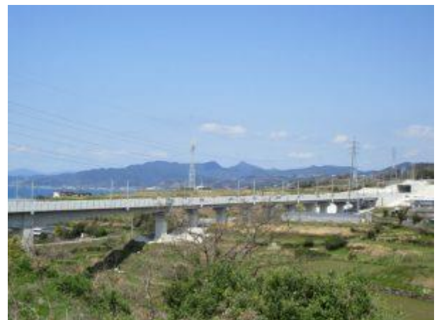
【完成した高架橋・橋りょう】
