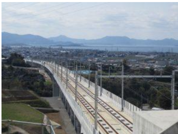
【完成した高架橋・橋りょう】
