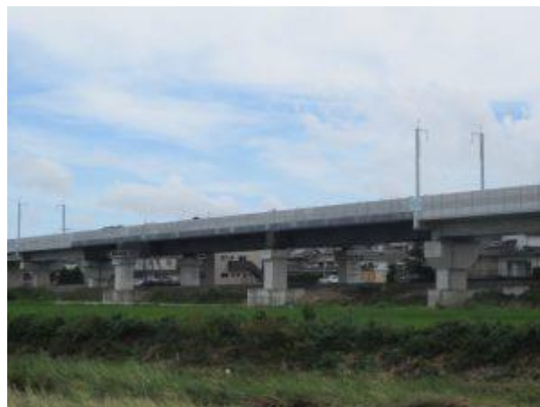
【完成した栄田 Bi(栄田線路橋)】
