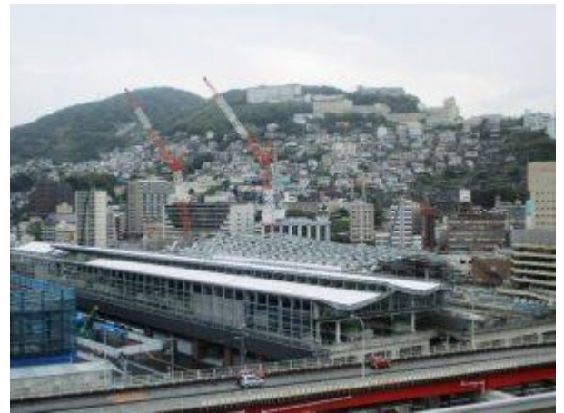
【工事状況(R2.8.28 撮影)】
