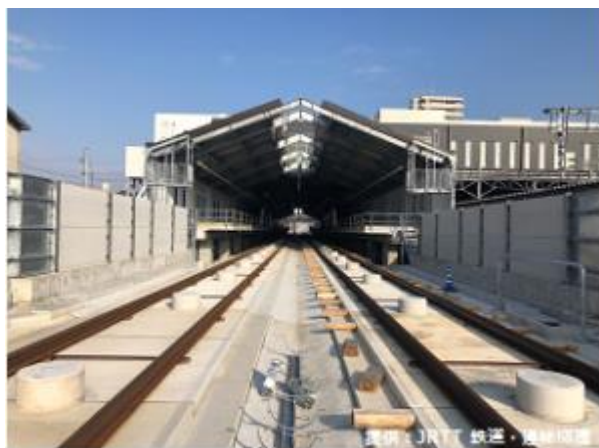
【完成したホーム部】(長崎駅側から諫早駅を望む)
