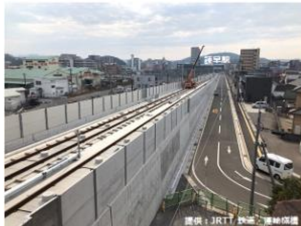
【完成した擁壁部】(新大村駅側から諫早駅を望む)
