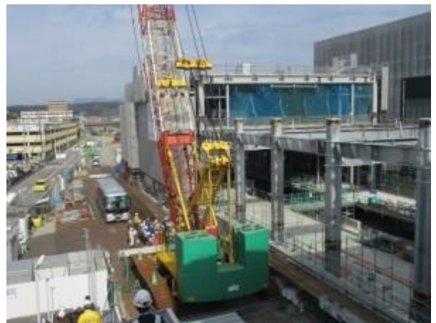
【見学した諫早駅の駅舎新築工事の様子】
