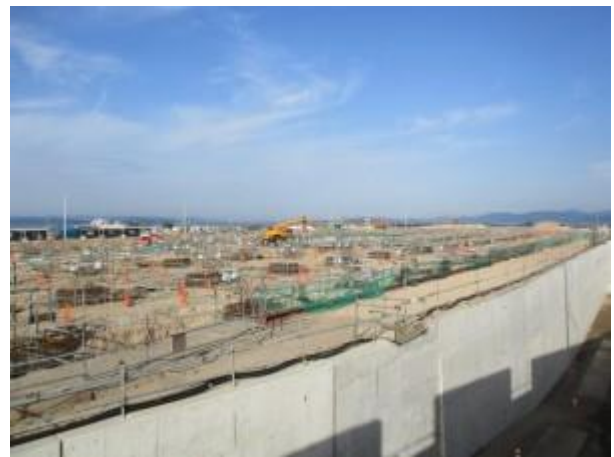
【見学した大村車両基地の工事の様子】
