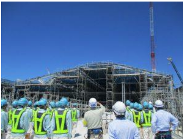
【長崎駅の高架上での見学の様子】
