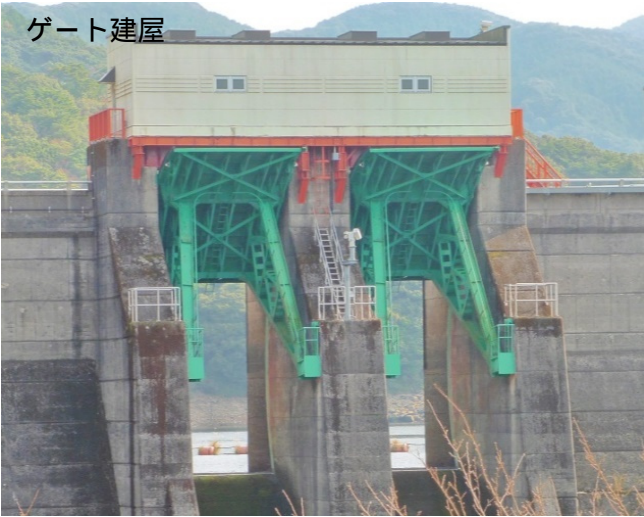
堤体左岸下流面下の利水放流設備
