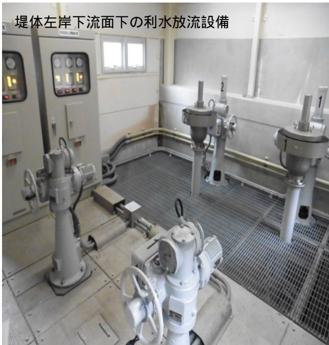
堤体左岸下流面下の河川維持水放流設備
