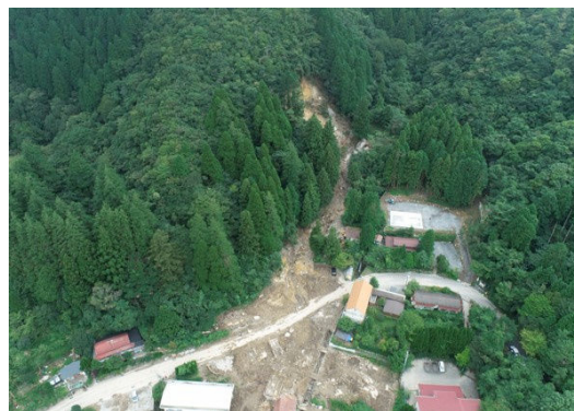
豪雨による土石流災害 (雲仙市)
