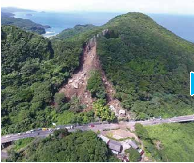
被災状況写真 (R2.7月撮影)
