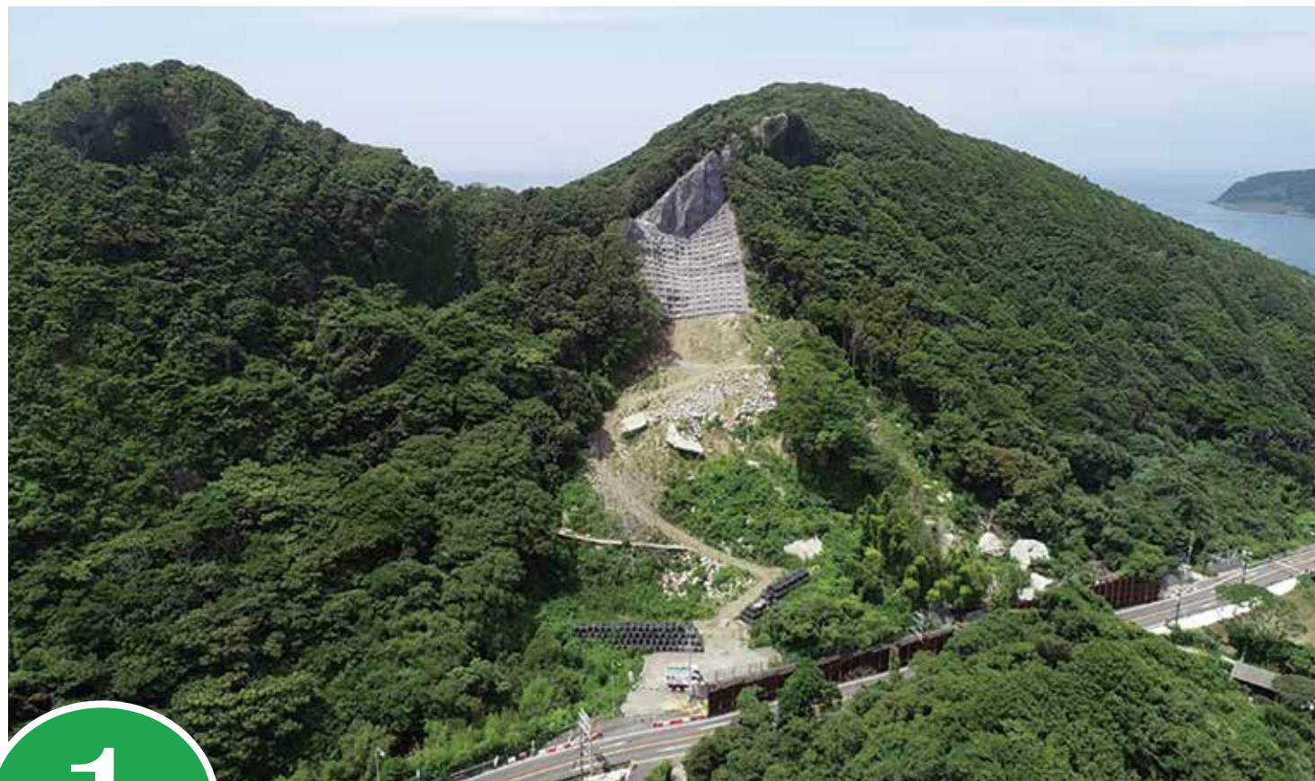
平戸市主師町(しゅうしちょう)白石地区 災害復旧状況
