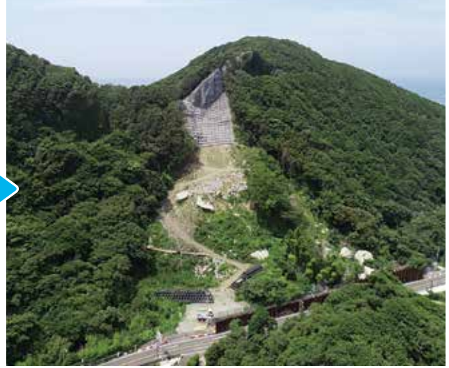
復旧状況写真 (R4.7月末撮影)
