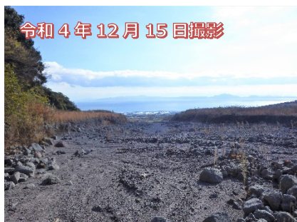
写真-6：安定した第7号治山ダムの堆砂状況
