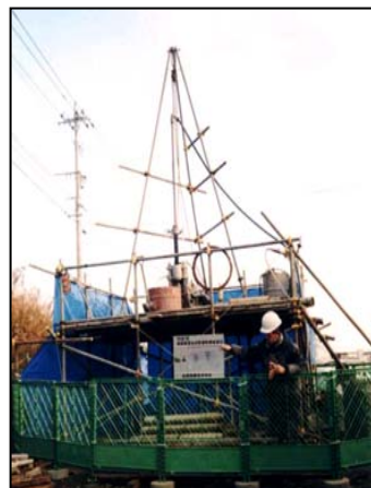
図-4 ボーリング調査の状況
