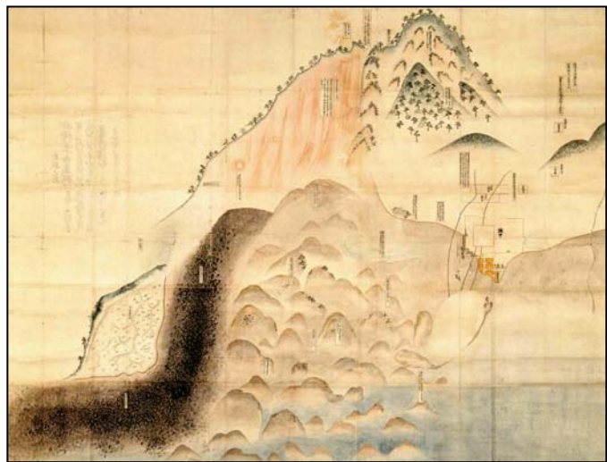
図-2 「島原大變」における眉山の崩壊と島原城下における地割れの様子を示した古絵図 （島原大變大地図：島原市立図書館松平文庫蔵）
