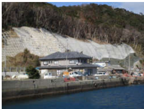
令和2年度竣工治山工事（左：長崎市、右：西海市）
