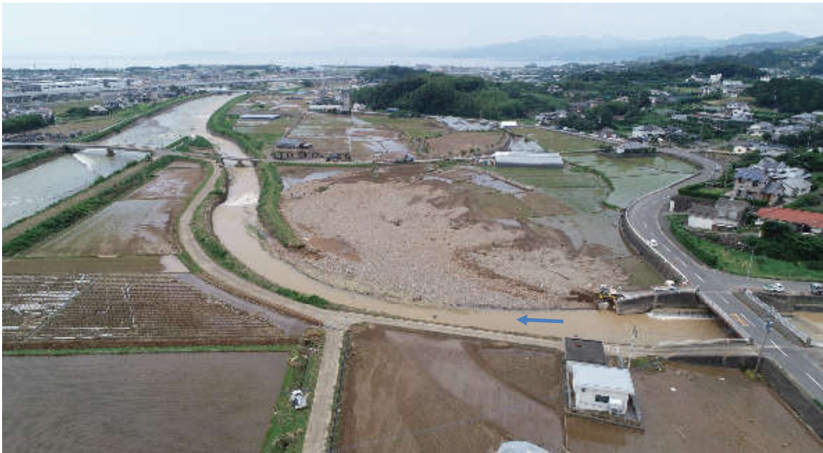
佐奈河内川(令和2年7月大雨時の被災状況)
