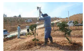
【支柱打ち込み】
