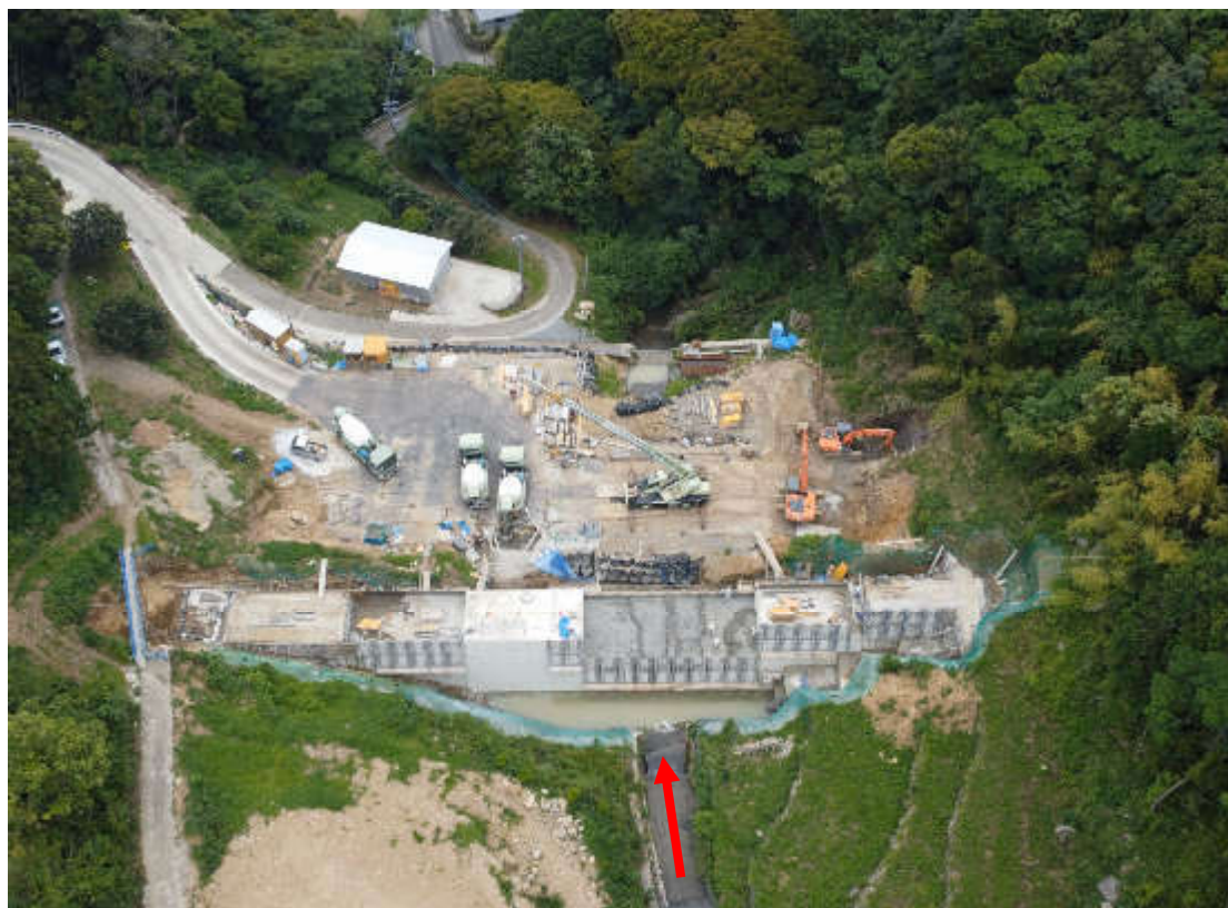
山口谷川砂防施工状況
