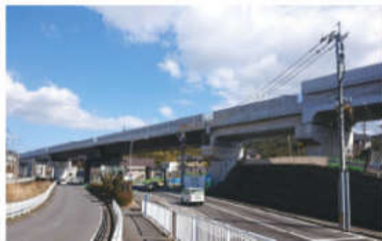
諫早市 宇都橋りょう(R3.2撮影)
