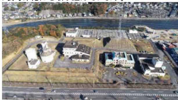
大村湾南部浄化センター
