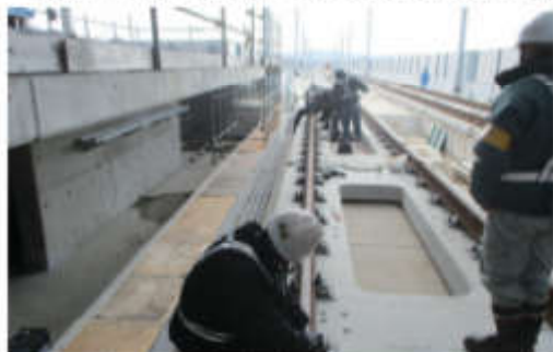
新大村駅付近の軌道工事状況(R3.1撮影)
