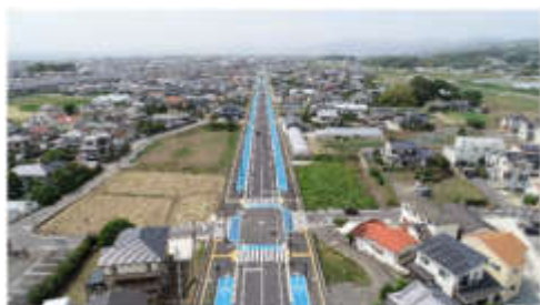
池田沖田線 供用部分
