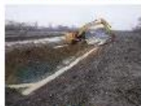
河道掘削 (石狩川水系、北海道開発局)
