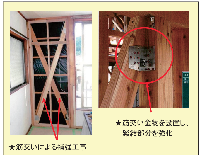
★ブレースを設置し、建物の強度を高め耐震性の向上を図る。
