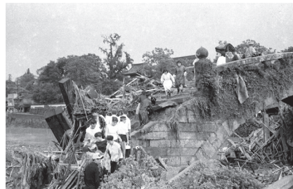
諫早大水害 (S32.7.25) の被災状況
