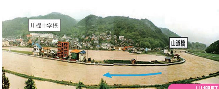
平成2年水害 (H2.7.2) の被災状況
