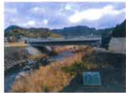
橋梁上部工 L=27.3m 上部工形式: 駅スタジョン方式PC単純T桁橋
