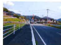
国道34号と町道川内線との交差点 佐世保・大村方面から撮影
