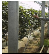
ブレースの増設
