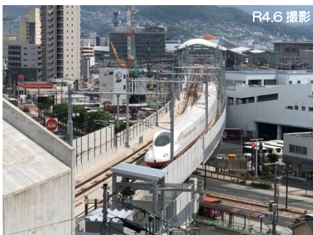
長崎駅付近での走行試験の様子
