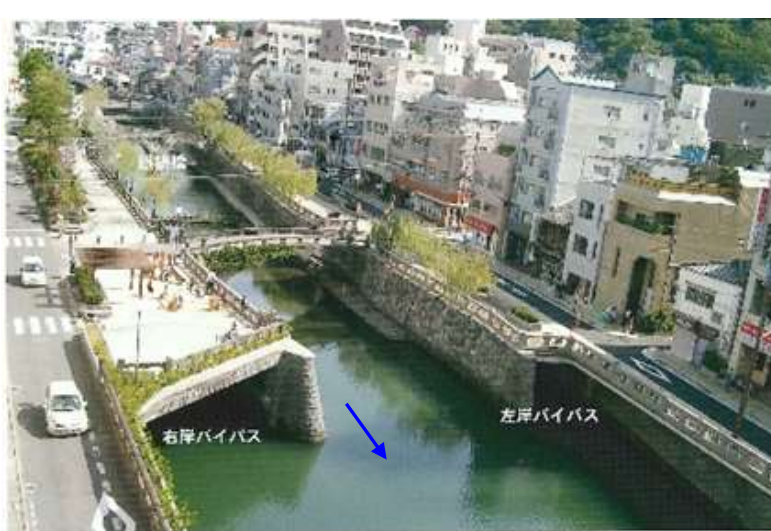
(左右岸バイパス水路完成)
