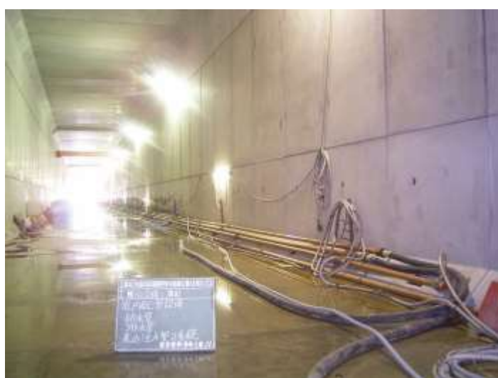
(据付完了状況)
