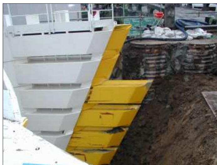
(シールドマシン掘削状況)
