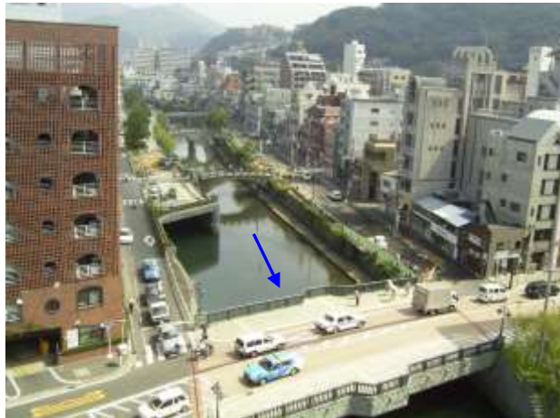
(左岸バイパス着工前)
