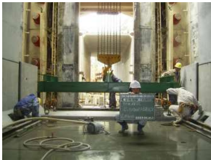
(底版据付状況)
