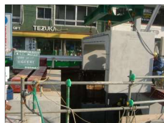
(頂版据付状況)
