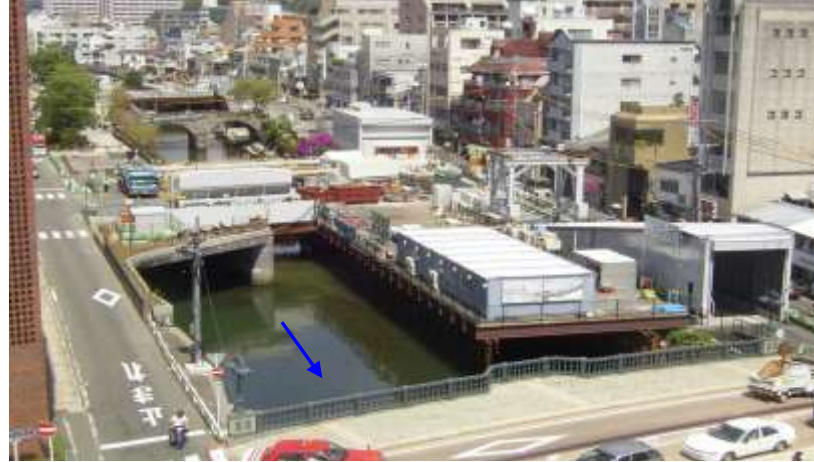
(左岸バイパス施工中)
