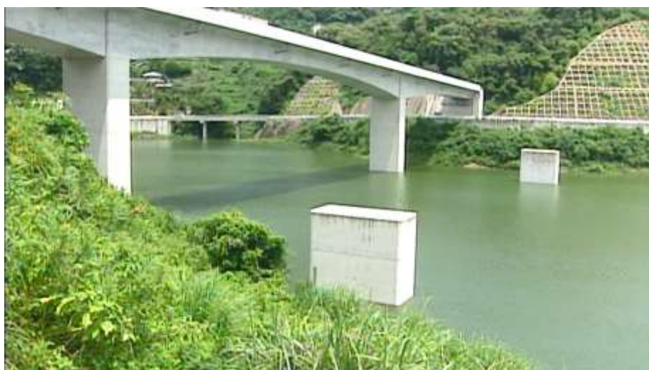
(左写真) 中尾ダム貯水池を横断する長崎自動車道（ダム建設当時）。将来の4車線化を見越して拡幅分の橋脚があらかじめ設置されています。
