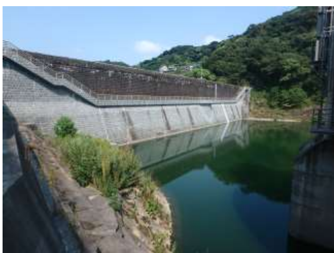
中島川の洪水を調節する本河内低部ダムの完成 (2011(平成 23)年度)
