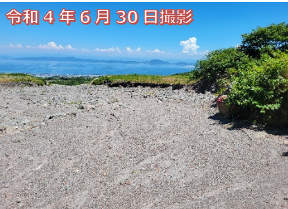
写真4：安定した第7号治山ダムの堆砂状況
