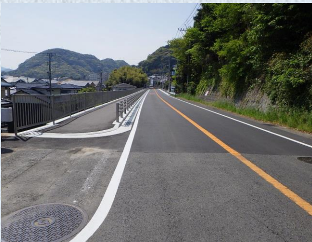
一般県道奥ノ平時津線 交通安全施設等整備工事（火籠工区）
