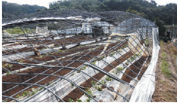
※県単独の支援対策で緊急的に復旧
