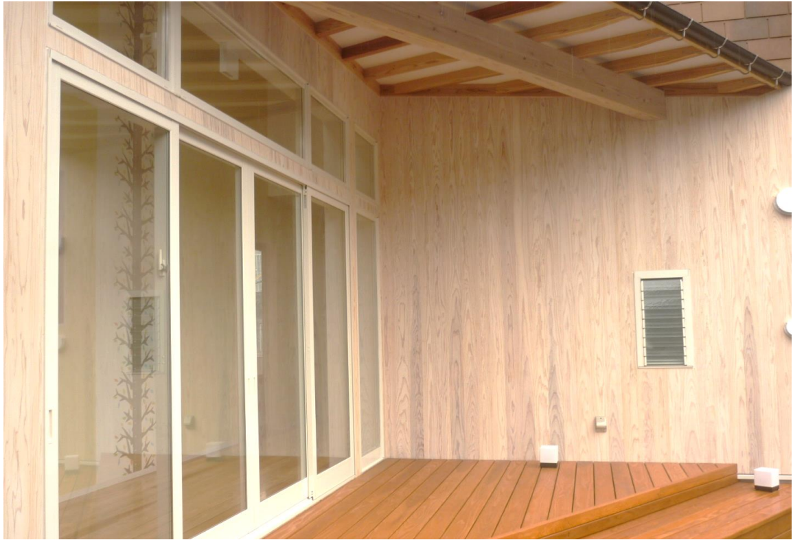
外壁、ウッドデッキ
