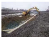
河道掘削 (石狩川水系、北海道開発局)
