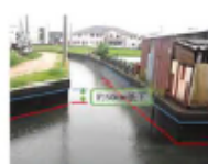
用水路の事前水位低下による雨水貯留 (吉井川水系、岡山市)
