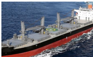
【デッキクレーン】
