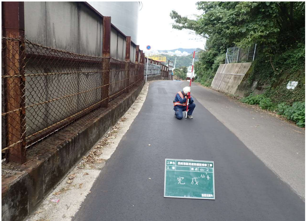
地点②着工後
