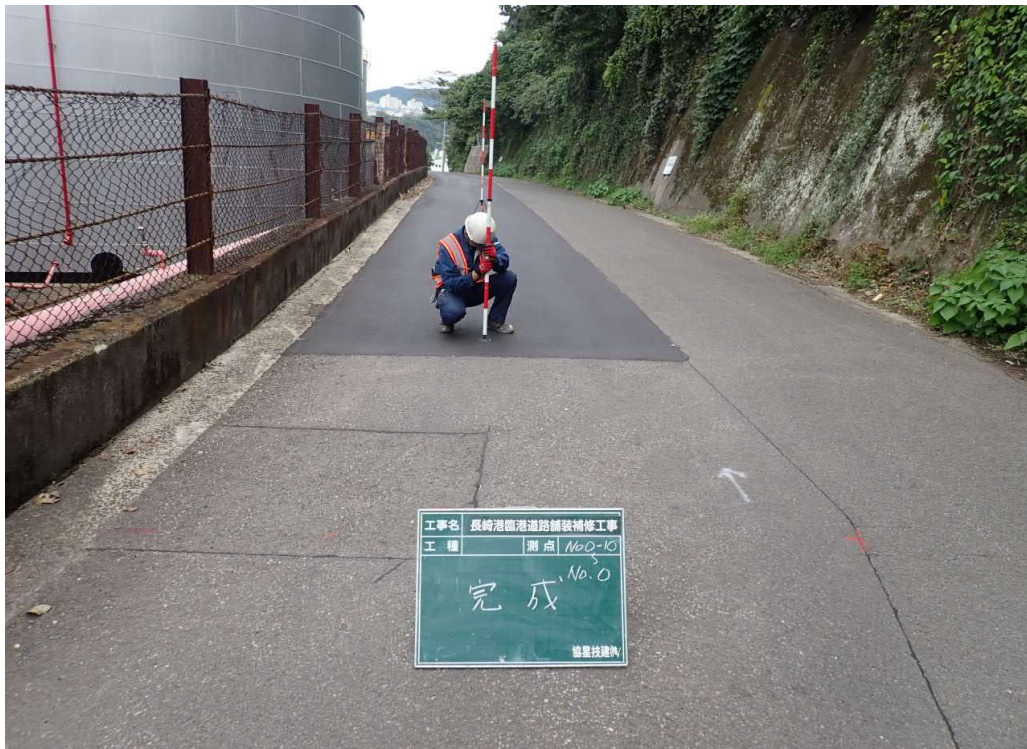
地点①着工後
