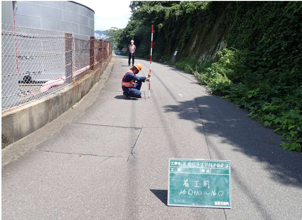
地点①着工前
