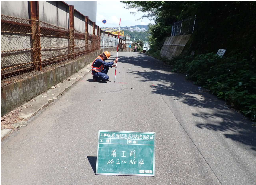
地点②着工前
