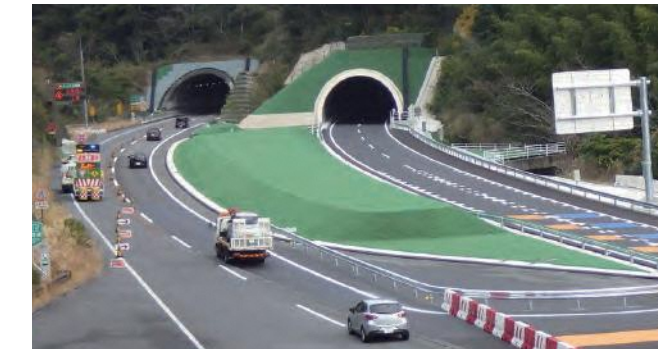
長崎トンネル(長崎IC側)
