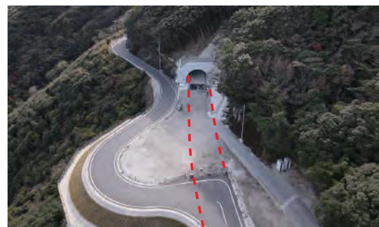
尾浦トンネル
