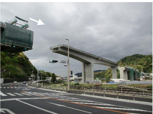
③写真中央の橋脚からの張り出しは完了し、今度は写真左側の橋脚から張り出しが行われています
