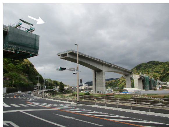
③写真中央の橋脚からの張り出しは完了し、今度は 写真左側の橋脚から張り出しが行われています (平成 31 年 4 月撮影)
