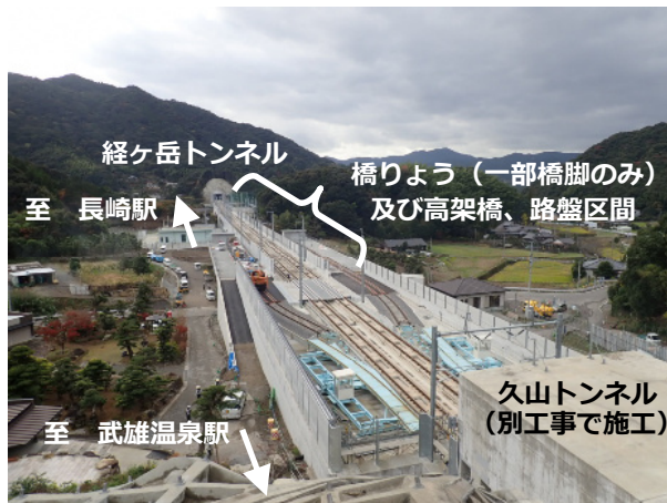
完成した経ヶ岳トンネルと久山トンネルの間
