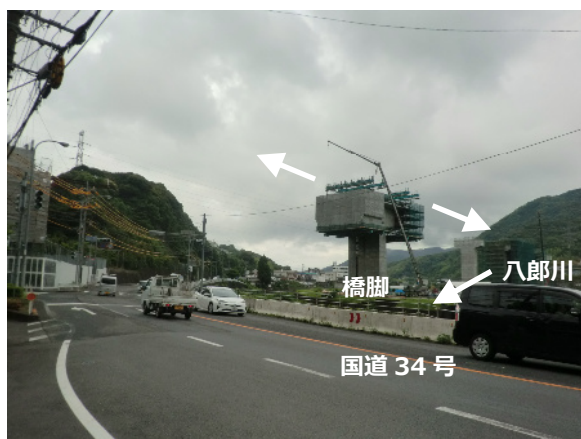
①これからだんだん左右に張り出していきます (平成 30 年 6 月撮影)
