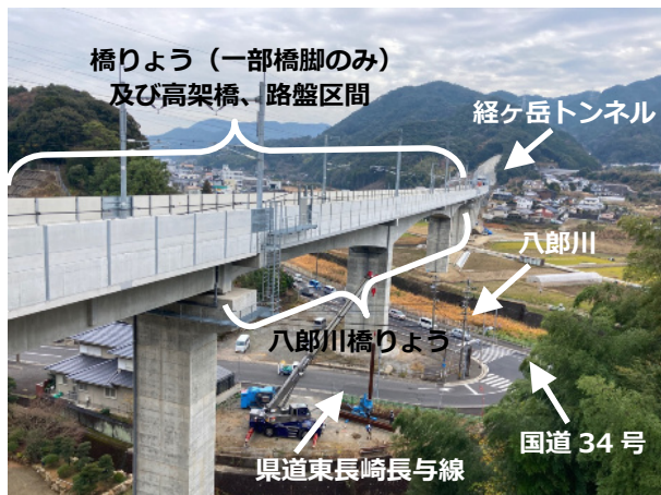
完成した八郎川橋りょう
