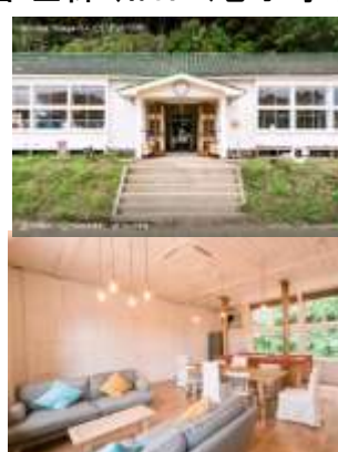
【管理棟(旧田尾小学校)】
