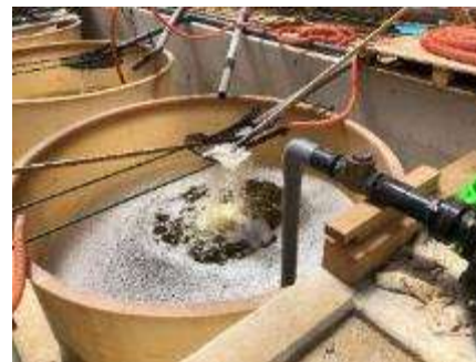
【循環ポンプ装置】
