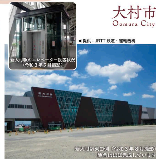
大村車両基地（令和3年8月撮影） 建築、電気、軌道、機械工事が進められています
