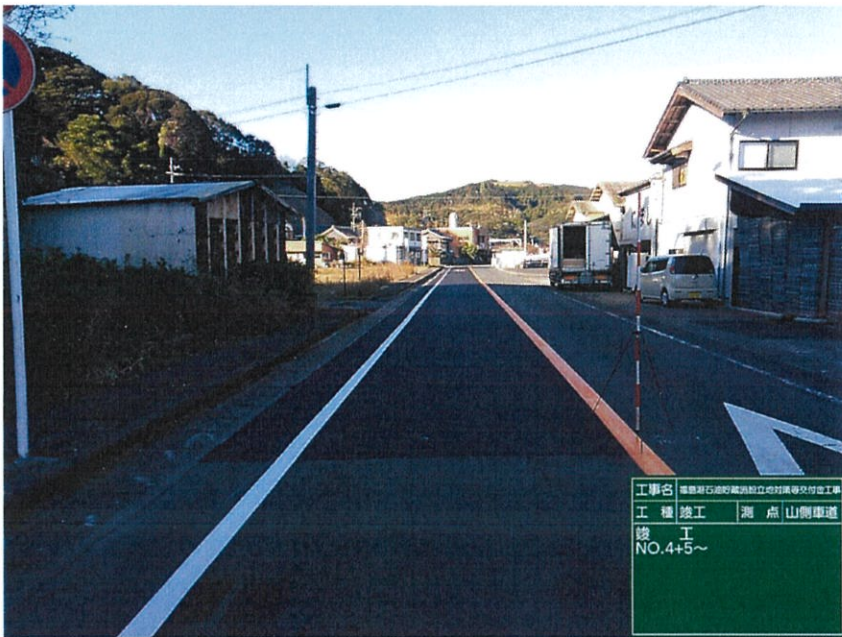
工種：竣工 測点：山側車道
