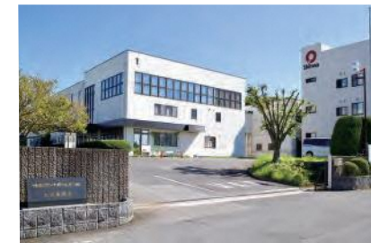
約1万3千㎡の敷地内に物流棟を増設中
