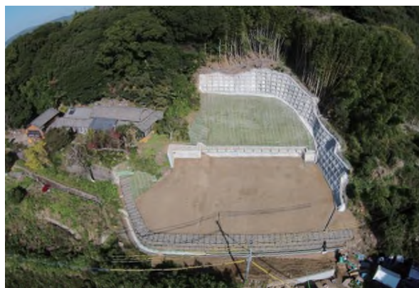
【地すべり防止工事】 南島原市口之津町新切地区
