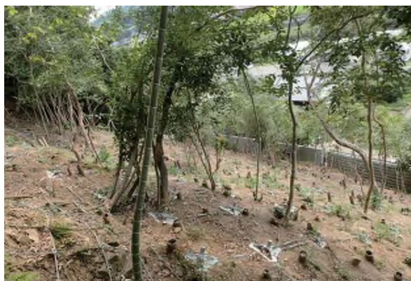
【地山補強土工】 北松浦郡佐々町古川地区
