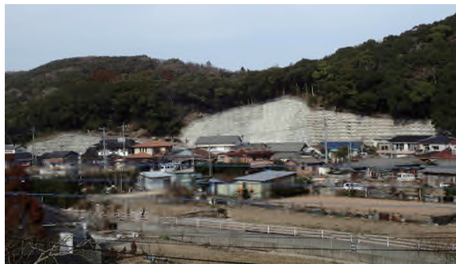
【法枠工】 対馬市美津島町久須保地区
