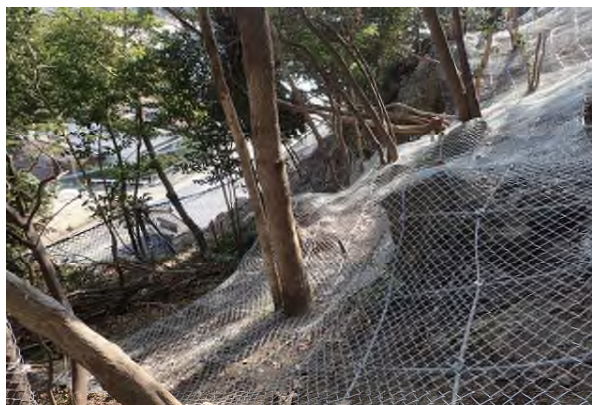
【落石予防工(固定工)】 対馬市上対馬町小鹿地区
