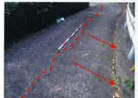
写真④ 道路の亀裂
