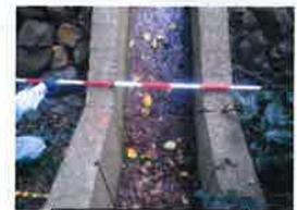
写真⑤ 水路工の亀裂
