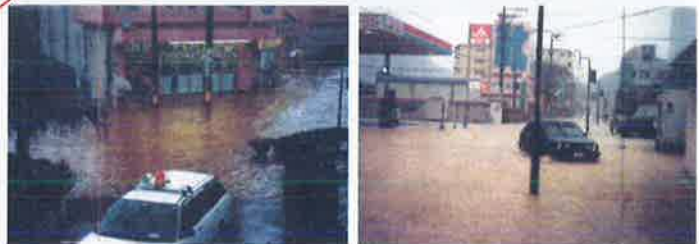
浸水状況 (平成14年9月洪水): 佐々町役場
