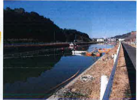
河床掘削状況
