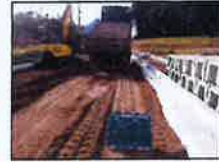
■軟弱路床土対策 サンドイッチ舗装工 (Fe石灰処理土使用)
