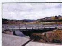
■壱河形式変更(図渠→橋梁) 加積橋(架設済)
