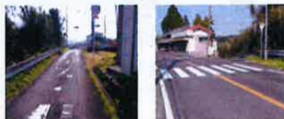
国道への急勾配での接続
