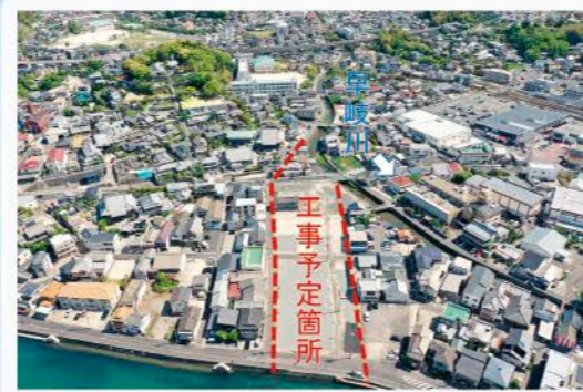
早岐川の工事予定箇所
