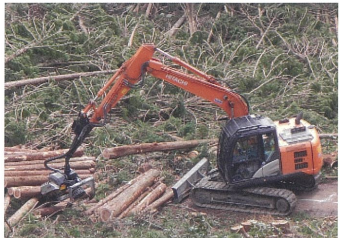
導入が進む高性能林業機械（プロセッサ）
