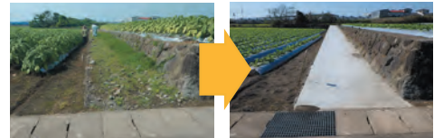
未舗装農道の舗装
