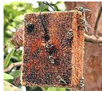
テックス板の設置状況
