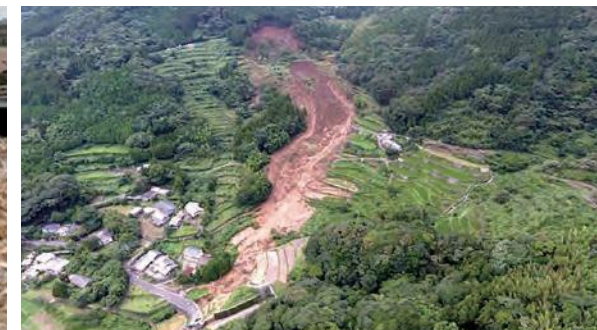
令和2年7月8日発生 牧の地地区の地滑り(佐世保市)
