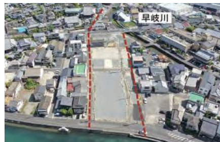
早岐川の工事予定箇所
