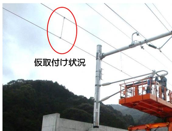
仮取付けを行ったトロリ線は、その後、張力をもたせるため、線をピンと張るなどの作業を行った後に、トロリ線を吊る架線に本取付けされます。
