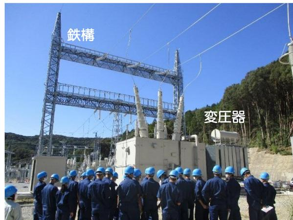
また、写真にある鉄構と呼ばれる構造物もとても大きなものになるので、施工の際は、しっかりとした基礎を築いた上に鉄構を組み立てて造られています。
