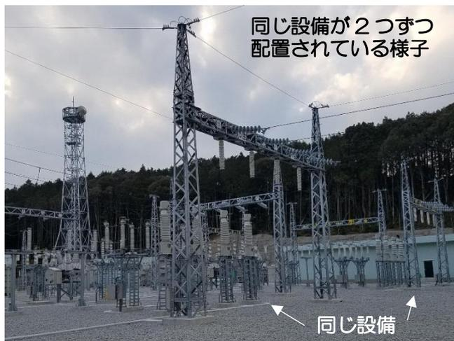
この『新諫早変電所』、新幹線へ電気を送り出す設備ですが、近くに新幹線の線路が見えません。実は、変電所の下に、鈴田トンネルという大村市と諫早市にまたがるトンネルが通っていて、変電所からの電気は、変電所内からトンネルへ続く穴（立坑）を通して本線へ送られています。
